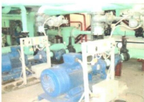
**TLM Ceramic исключает конденсатообразование на трубах холодной воды.
